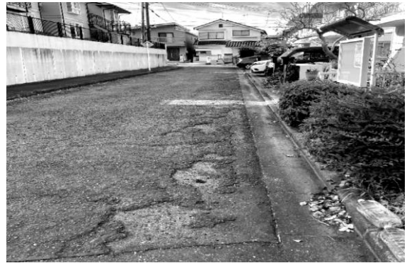
▲損傷が著しい66・67号棟南側から補修工事を進めてもらいます
